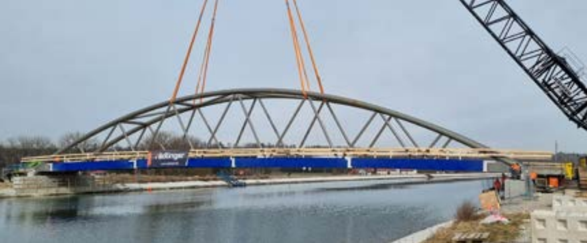
Mit einem 600-Tonnen Raupenkran wurde diese 60 Meter lange Brücke über den Innkanal eingehoben.
