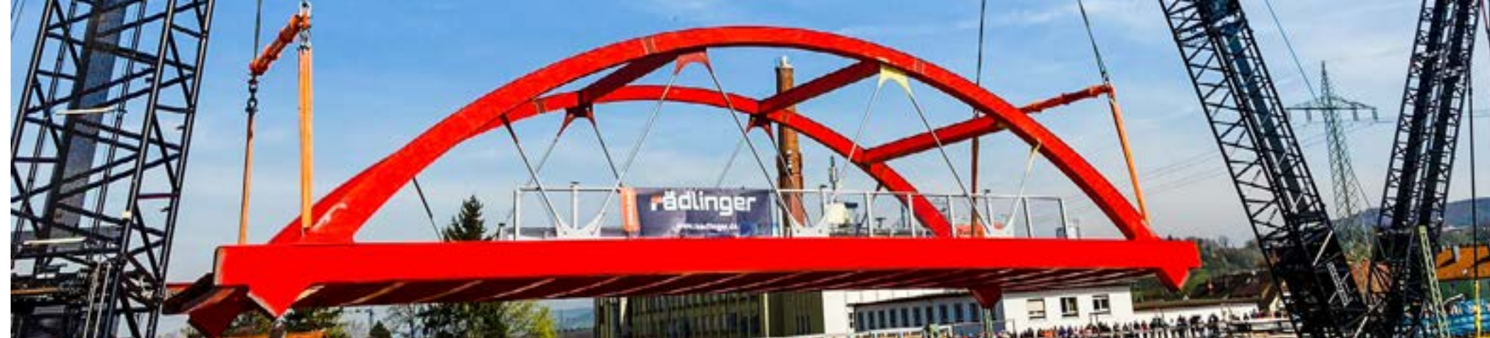
Die 320 Tonnen schwere Piastenbrücke wurde vor zahlreichen Zuschauern mit zwei Kränen eingehoben.
